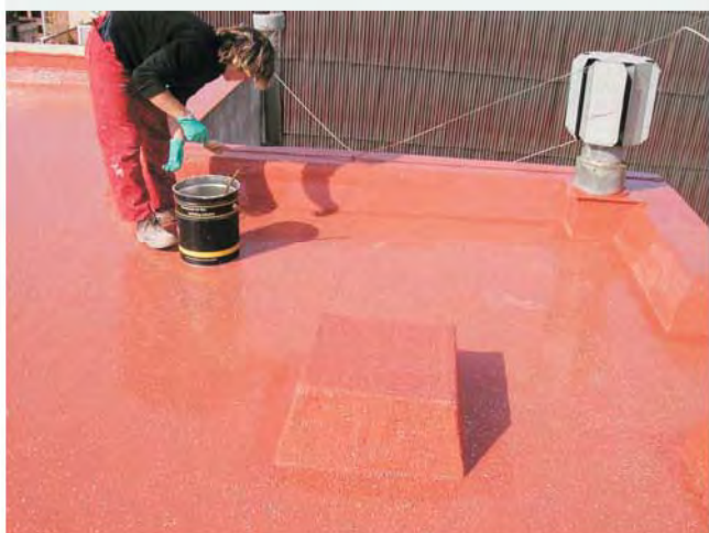
Impermeabilización Cubierta transitable con Chips decorativos Polinyà 2003
