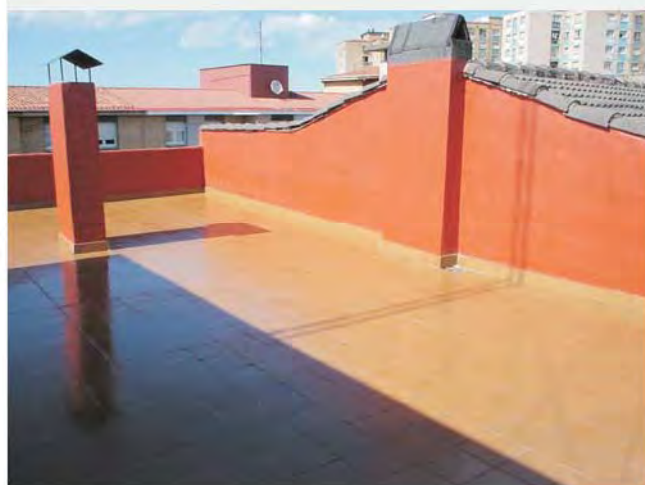
Impermeabilización Cubierta con revestimiento encolado Gijón 2004
